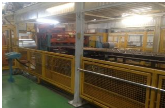
Figura 6 - Poço Auxiliar para Desbobinamento atendendo a norma NR-12
